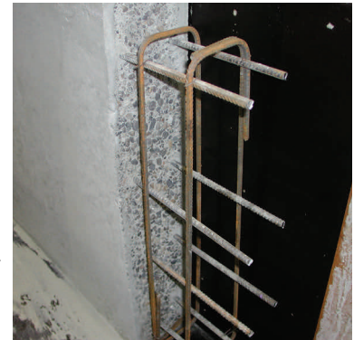
Foto: Abschnittsfuge mit aufgerauter Oberfläche
