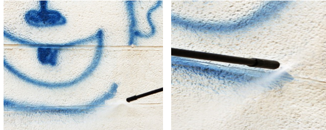
Bei Graffiti-Verschmutzung: Fläche mit Hochdruckreiniger reinigen. Danach gereinigte Fläche wieder neu mit PROWALL beschichten.
