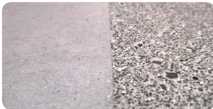
Links: „normaler“ schalungsglatte Beton
