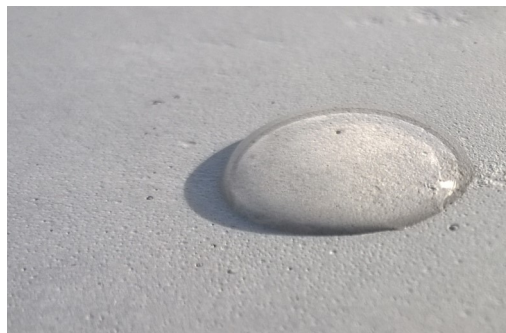
Sichtbeton mit COLORTEC® finish
