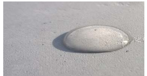
Sichtbeton mit COLORTEC® finish
