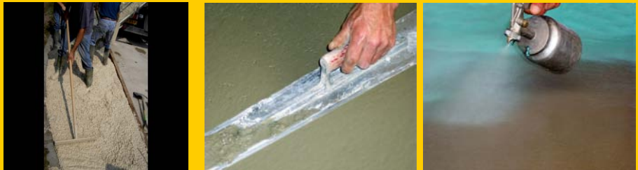
Tag 1 - Frischbeton einbauen, CSE Entaktivierer aufspritzen ...
