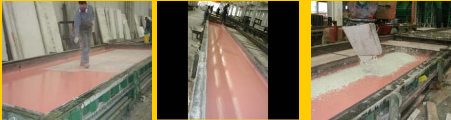
Tag 1 - CSE Entaktivierer anwenden, Betonieren ...
